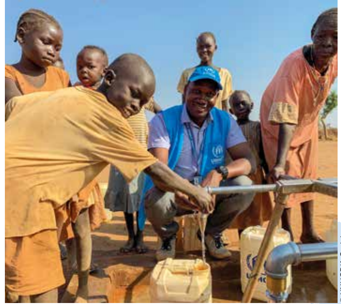
Jamjang, Südsudan: Patrick Okello und sein Team sorgen für sauberes Trinkwasser und errichten sanitäre Einrichtungen.
